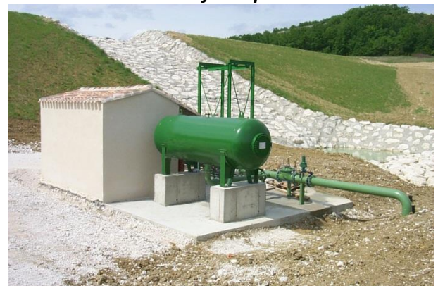
Réservoir hydropneumatique à vessie de 4m 3 25/37,5 bar en protection anti-bélier sur une station de pompage
