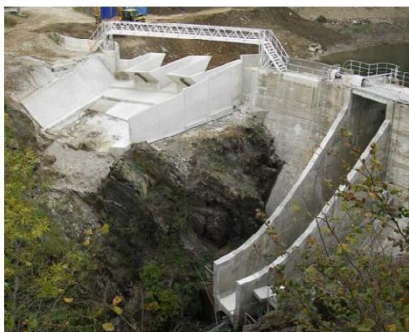
Figure 2 : Evacuateurs de crue du barrage de Goulours : ouvrages sur site et modèle réduit à l'échelle 1/25 e (EDF R&D/LNHE).
